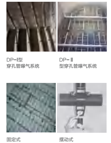
穿孔管曝气系统图片
